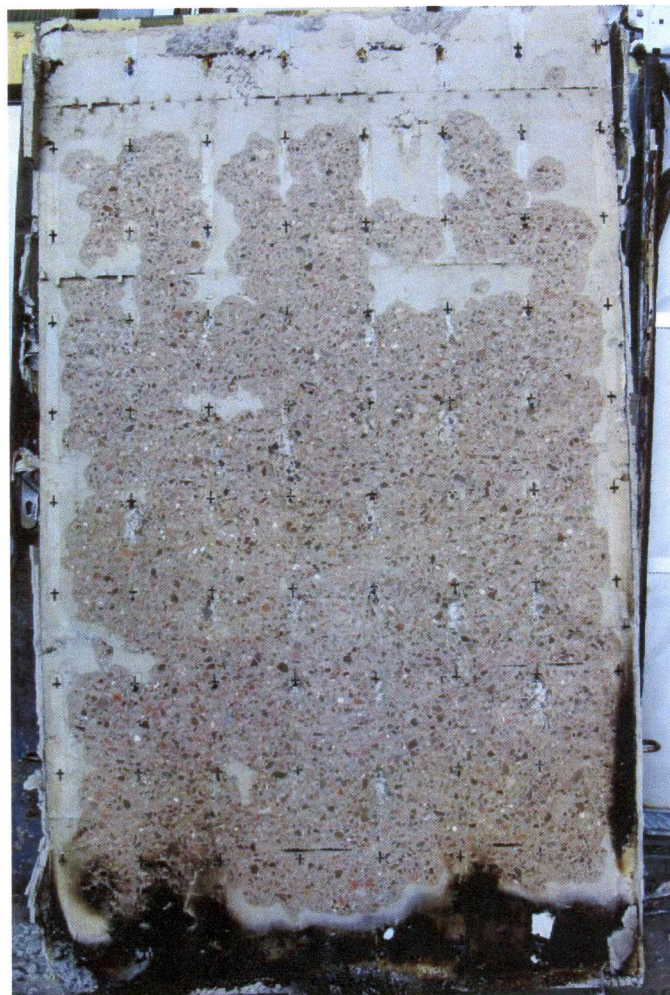
Рис. 5. Хрупкое разрушение бетона с обогреваемой стороны (опытный образец № 1).
